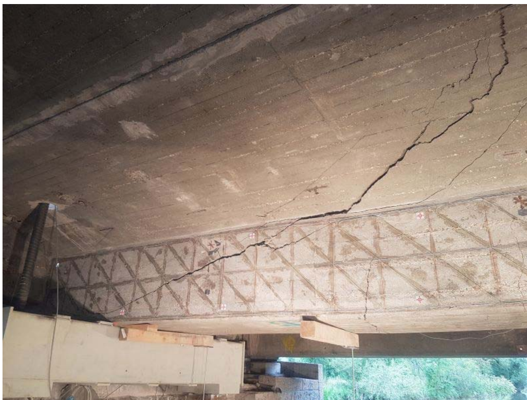
Рис. 2. Один из железобетонных автомобильных мостов в Кельне
