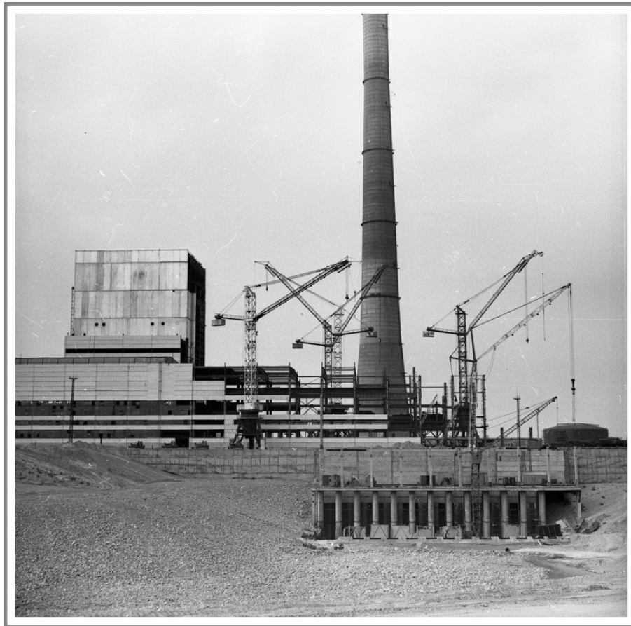
Фото 1. Возведение уникального инженерного сооружения дымовой трубы высотой 330 метров на Экибастузской ГРЭС № 1, в скользящей опалубке разработанной В. О. Гидроспецстрой (главный конструктор Марина Матвеевна Тринкер), осуществлено с применением СДБ и достигнуты самые высокие темпы и качество. Впервые в мире строительство уникального сооружения происходило круглогодично: летом 1978 года при температуре плюс 55 градусов, зимой 1978/1979 при температуре минус 40 градусов Цельсия. Автор технологии и бетона А. Б. Тринкер
