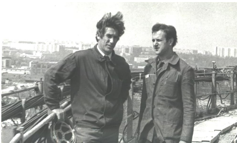
Фото 2. Одно из уникальных высотных сооружений энергетической системы страны, построенное с ПАВ, особотонкостенная оболочка градирни рассчитана на 100 лет работы при градиенте температур: внутри плюс 40–60 градусов, снаружи от минус 50 до плюс 50 градусов Цельсия, по погоде. Электроэнергию и тепло дает ТЭЦ-25 Мосэнерго, справа главный технолог Минэнерго СССР А. Б. Тринкер, слева директор станции, 1977 год
